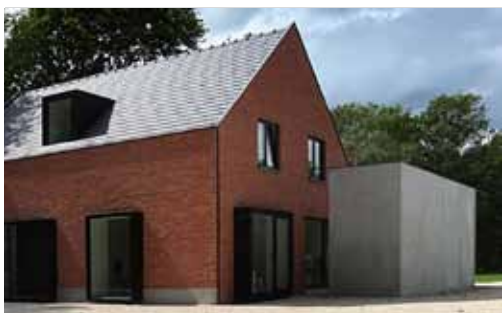
Hoge gootlijn en gevelopeningen als gaten in de gevel
