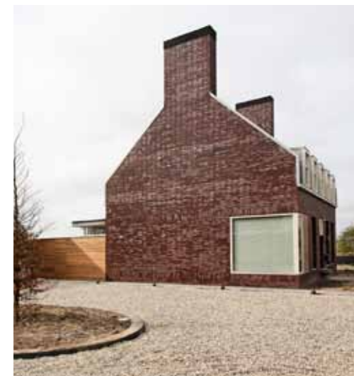
Schoorsteen als tuit van tuitgevel
