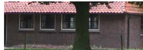
Behoud van bestaande gevelindeling
