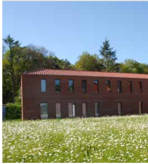
Massief bakstenen volume
