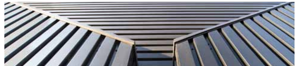
Geleding in het gevelvlak
