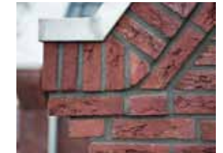
Metselwerk als gevelafwerking
