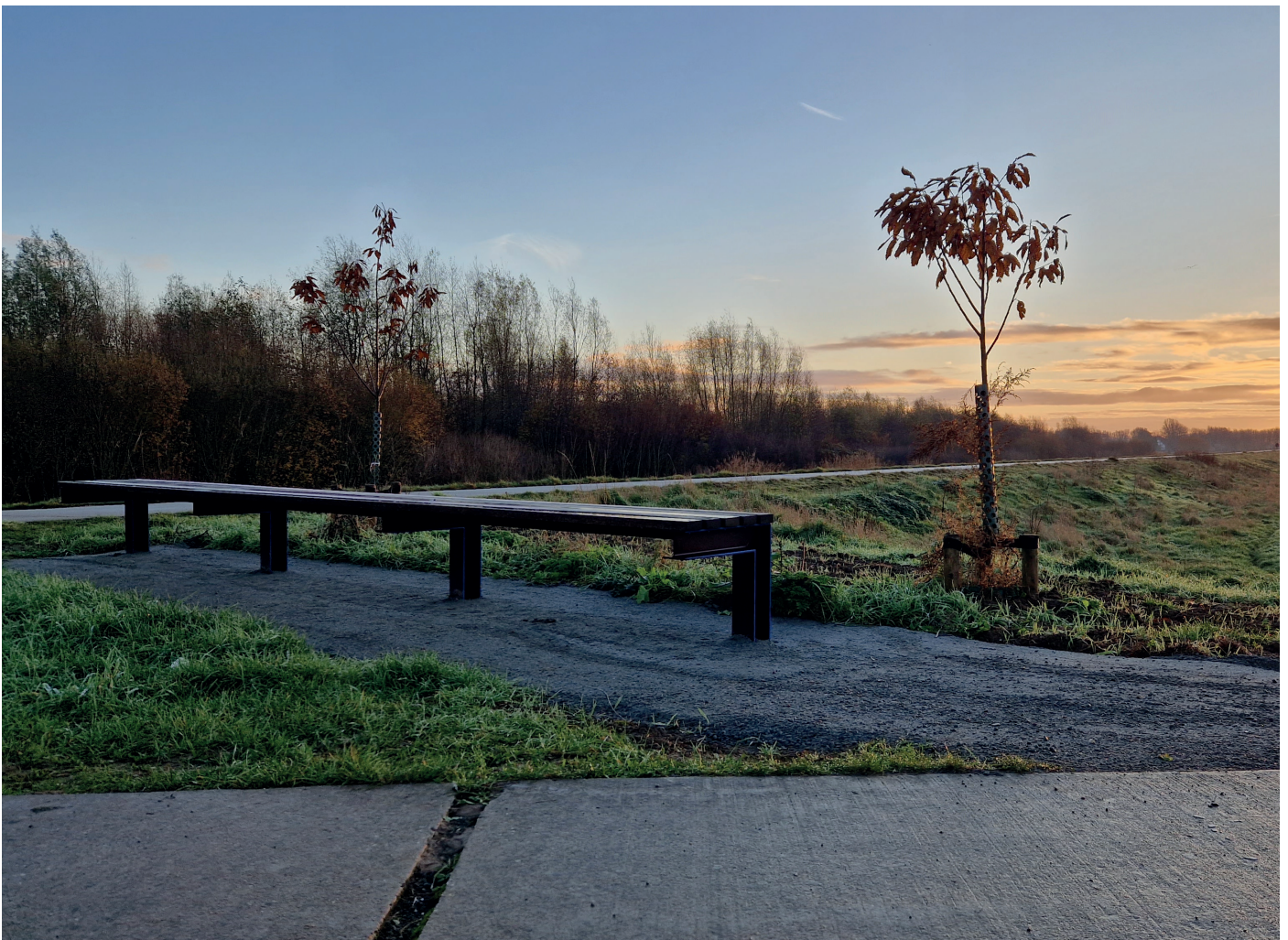
Onder verschillende bankjes en panelen is halfverharding aangebracht wat zorgt voor een betere toegankelijkheid.
