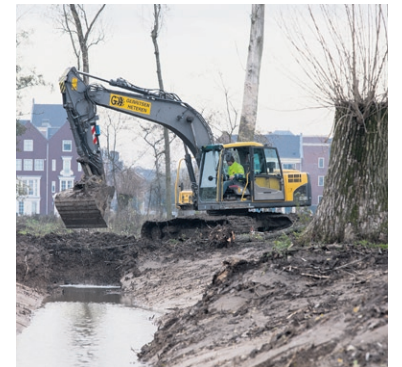
Aanleg van de sloten en oevers in het Speelbos.
