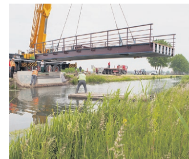
De brug aan de Lingewal wordt geplaatst.
